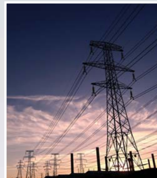
Equipo de conmutación de subestaciones de energía eléctrica
